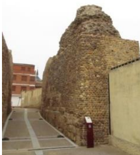
マンシージャの城壁
